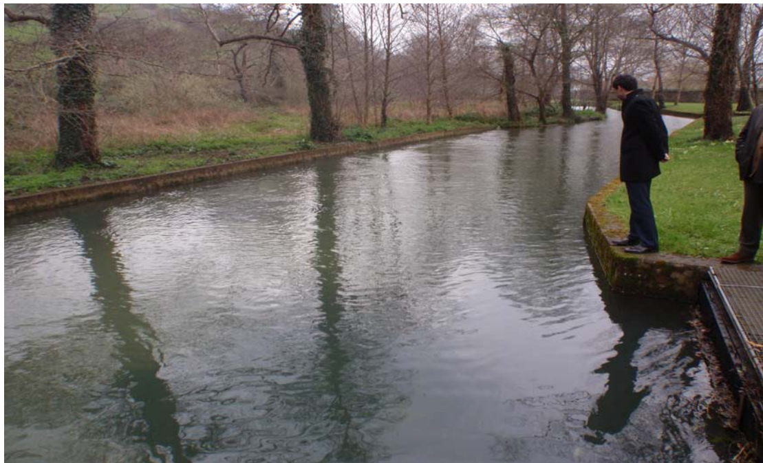
Fotografía 5.- En el ángulo inferior derecho, entrada de agua al azud.
