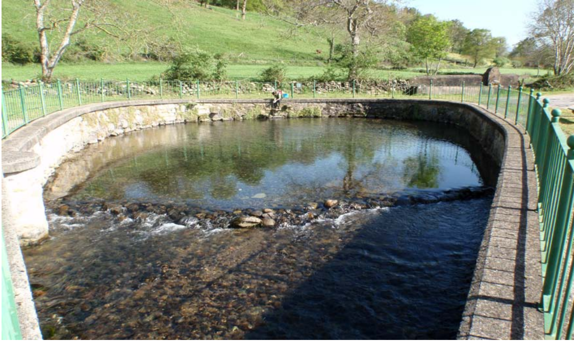
Fotografía 2.- Captación del manantial de La Pila, nacimiento del río del mismo nombre.
