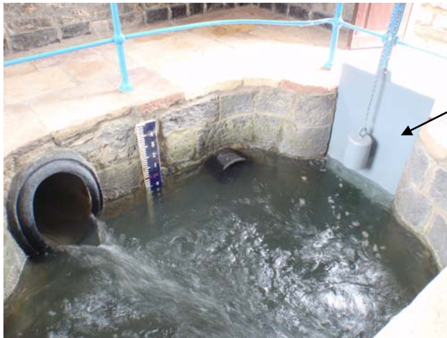
Fotografía 16.- Detalle de la compuerta que dirige el agua a la balsa-piscina de El Arca.
