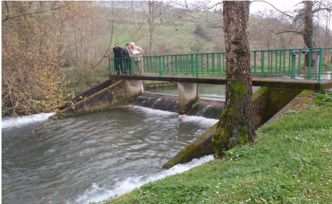
Fotografía 4.- Vista del azud del río La Pila.
