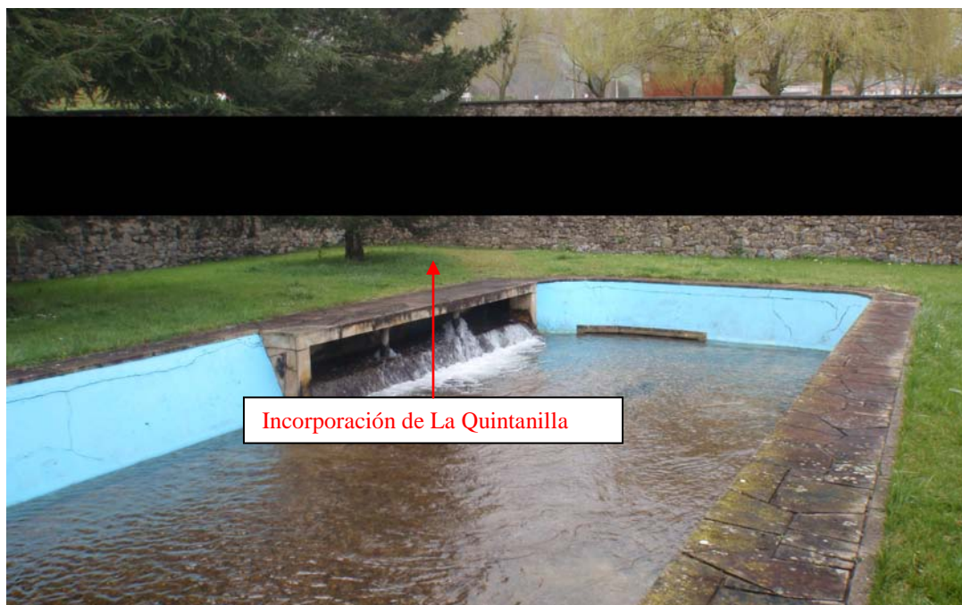
Fotografía 10.- Balsa de captación del manantial de La Sovilla e incorporación del caudal del manantial de La Quintanilla.
