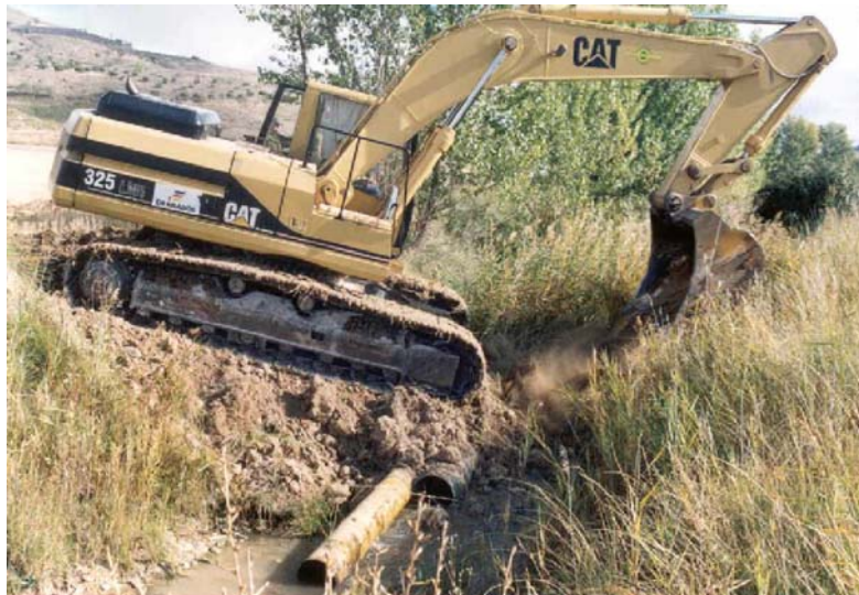
Fotografía 2: Instalación de la pista de trabajo y de la vaina en río Cigüela al comienzo de las obras en el otoño de 2001.
