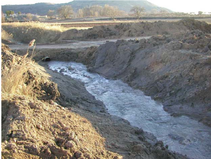
Fotografía 3: Pista de trabajo instalada en río Valdepineda previo a la fase de rehabilitación en el invierno de 2002 (momento AR, ver en texto página 12).
