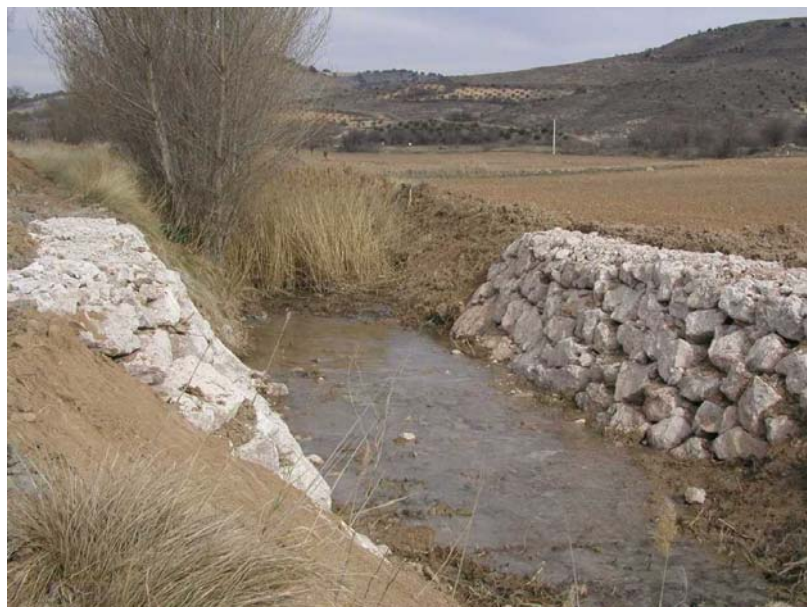
Fotografía 4: Río Cigüela en una etapa inicial de la fase de rehabilitación, tras colocar la escollera en las riberas (momento DR, ver en texto página 12).
