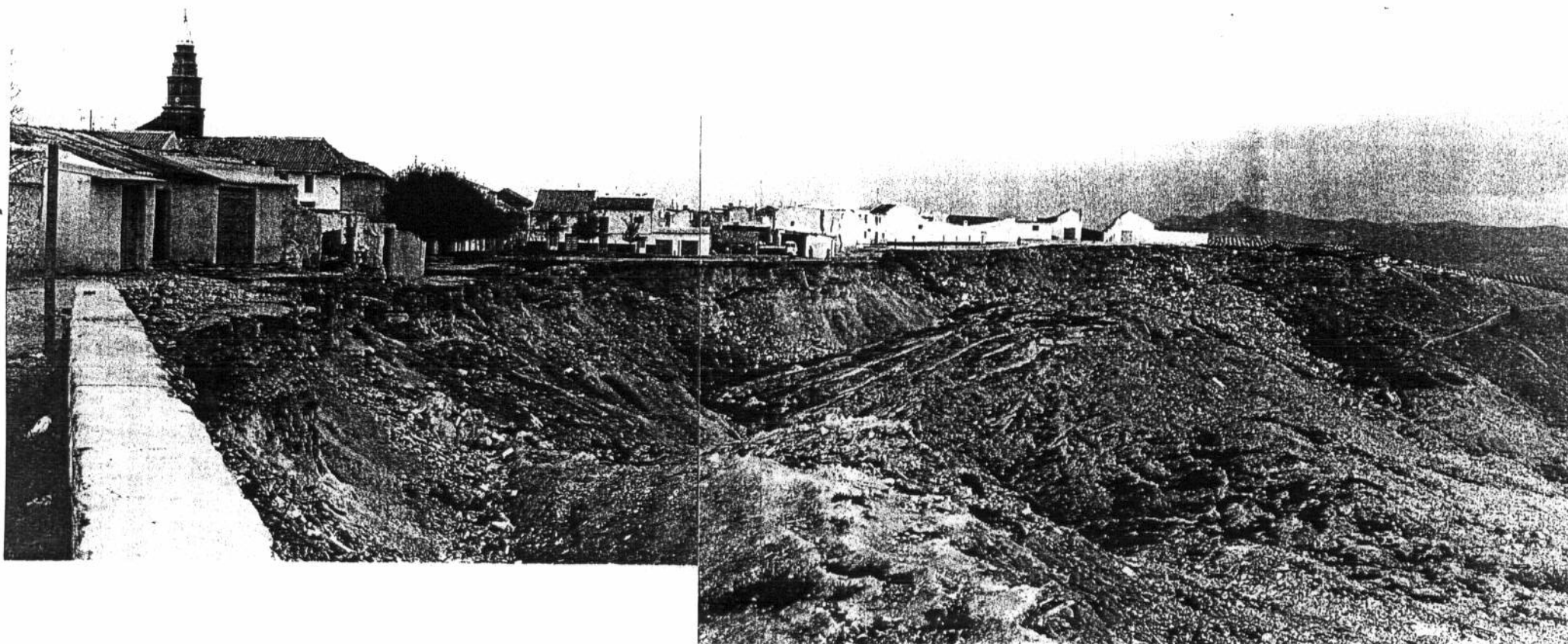
FOTOGRAFIA 7: Vista general del escarpe principal de coronación. El muro que aparece en el vértice inferior izquierdo ya ha caído.
