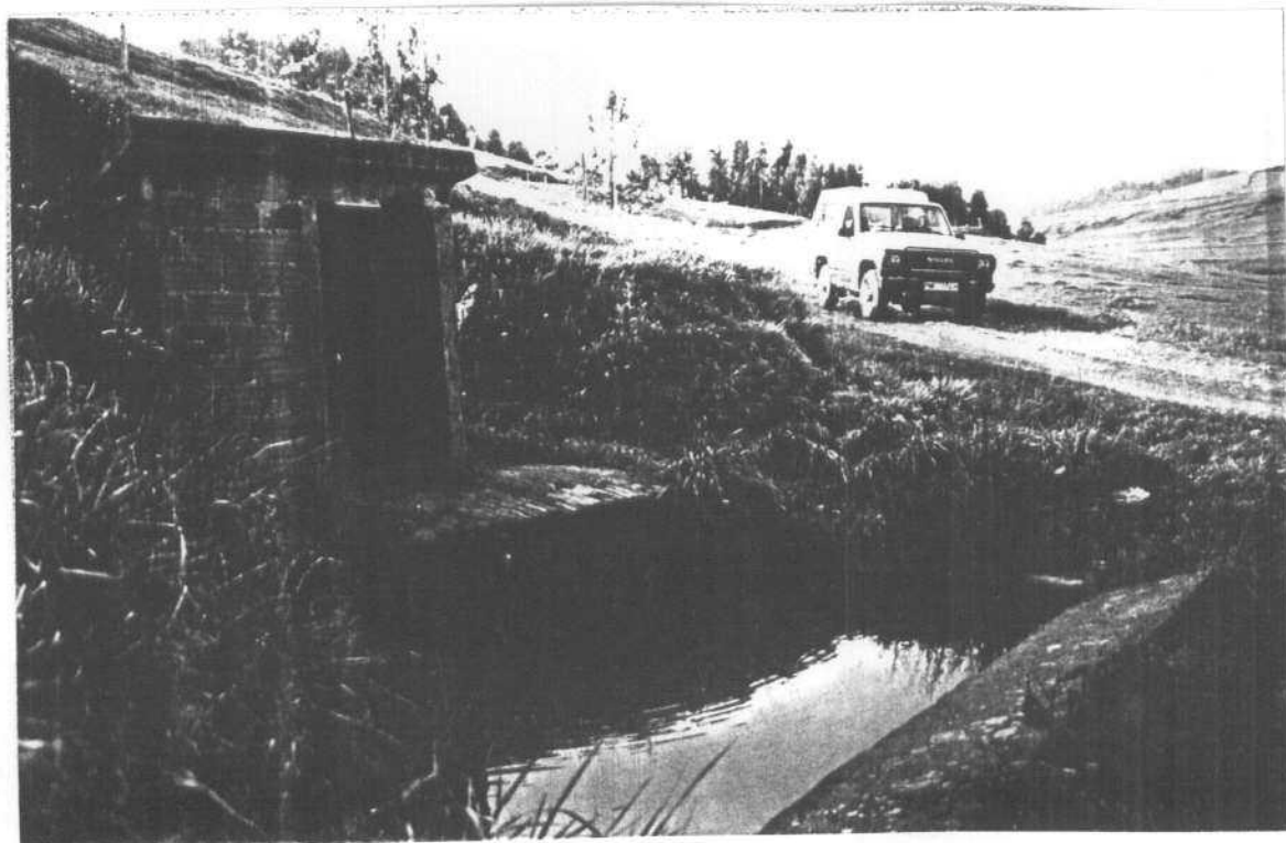
Foto 17.- Fuente El Quele (1204/4/0040), situada sobre una antigua explotación de Barita.
