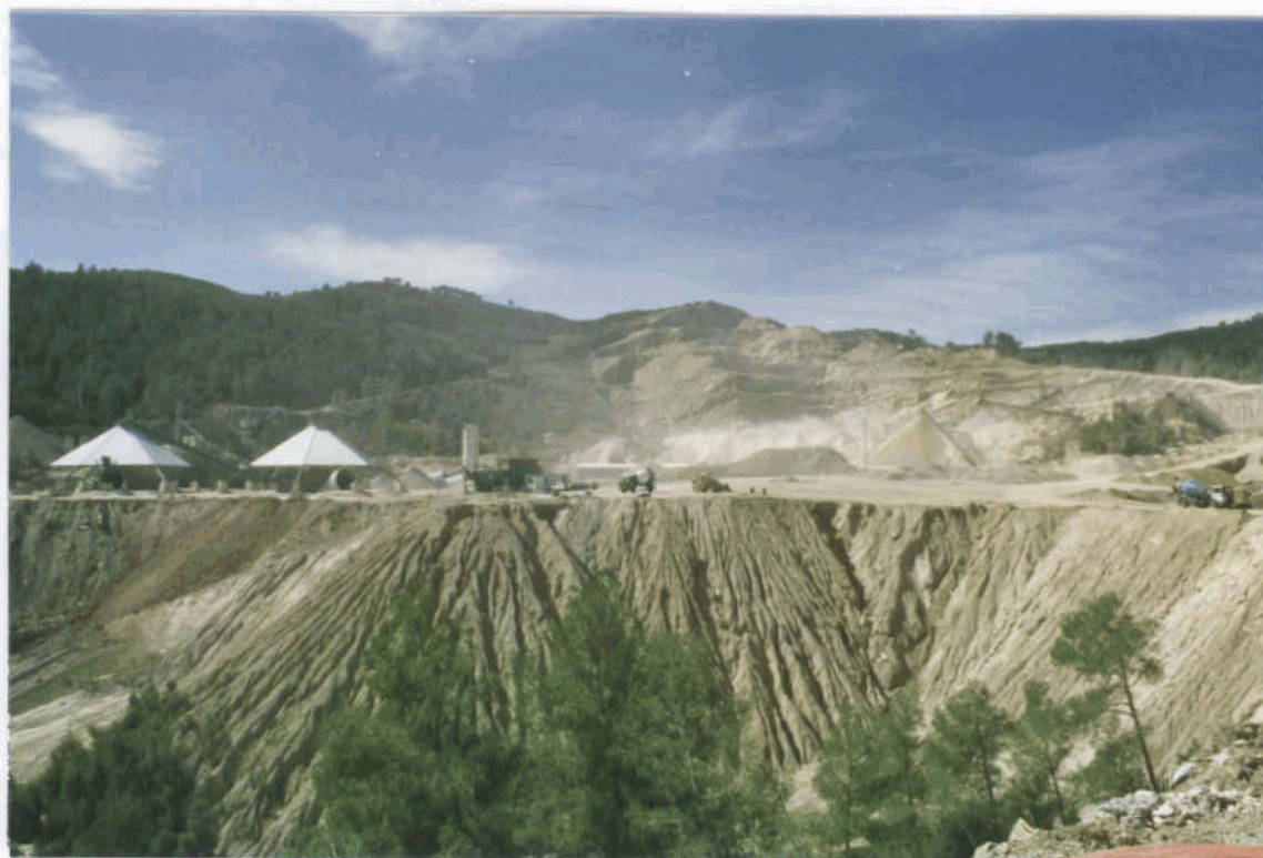
Foto núm. 7. Erosión y acarreamiento en la estructura 36-15-3-1.
