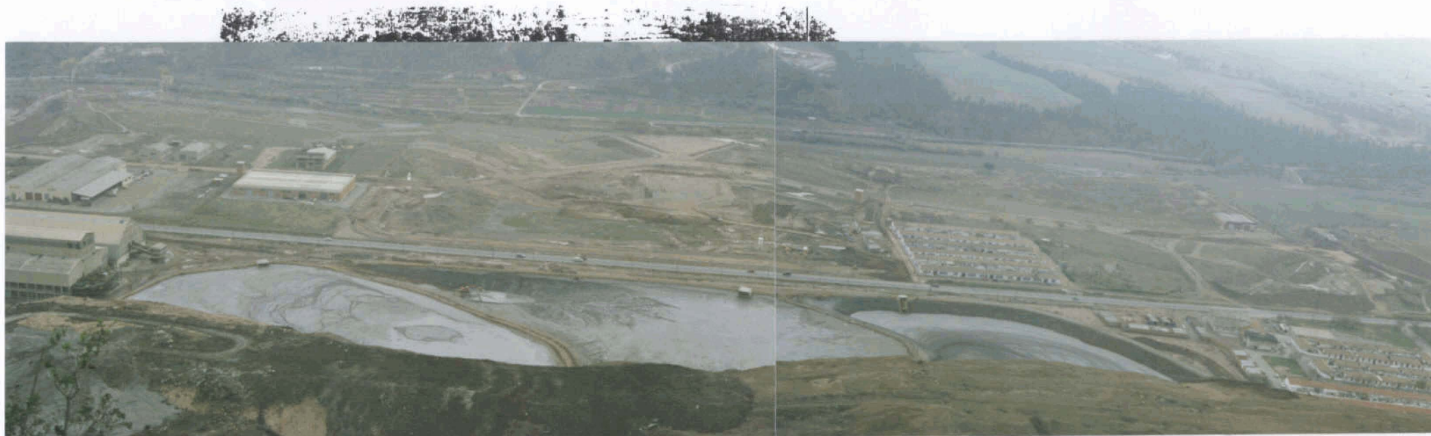
Foto núm. 13. Panorámica de las estructuras 36-14-2-1 y 36-14-2-2 en Sallent.
