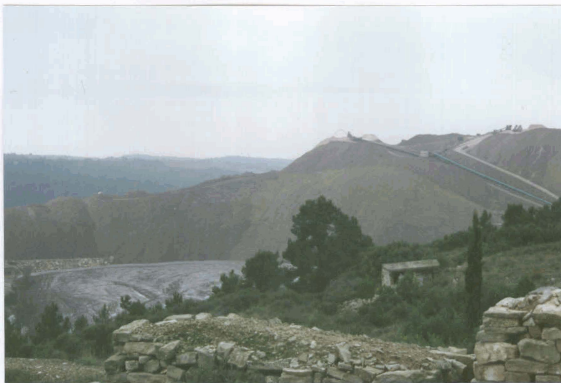
Foto núm. 12. Detalle de la estructura 36-14-1-1 de ERCROSS en Sallent: escombrera con una zona de vertido de lodos.
