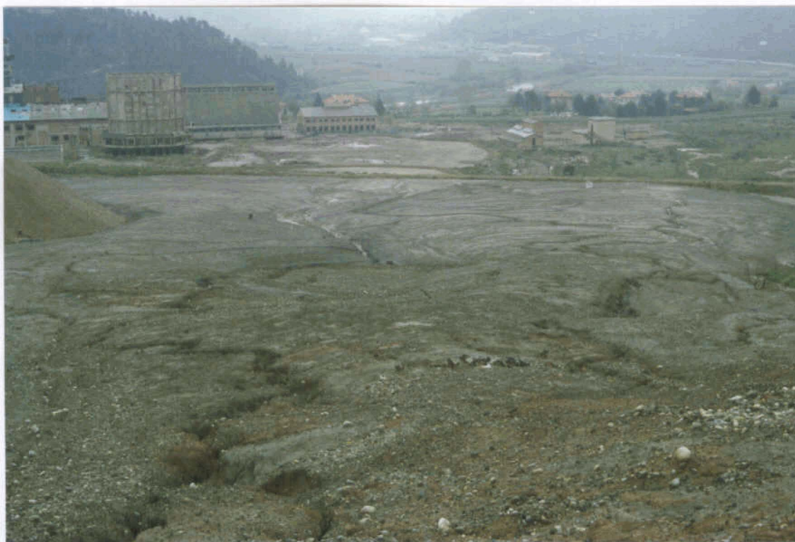
Foto núm. 9. Detalle de la erosión en los materiales de la balsa 36-14-2-1 de la minería de potasas.
