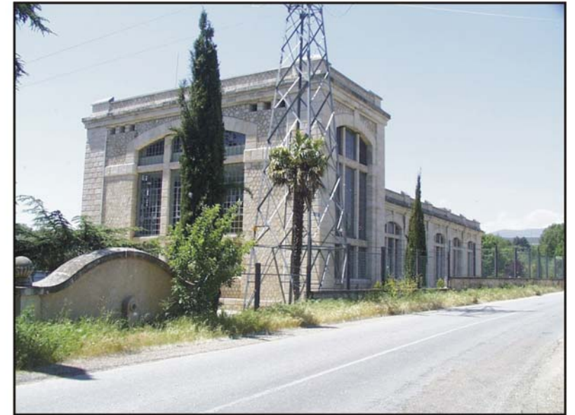
Figura 45: Central hidroeléctrica de Santa Lucía.
