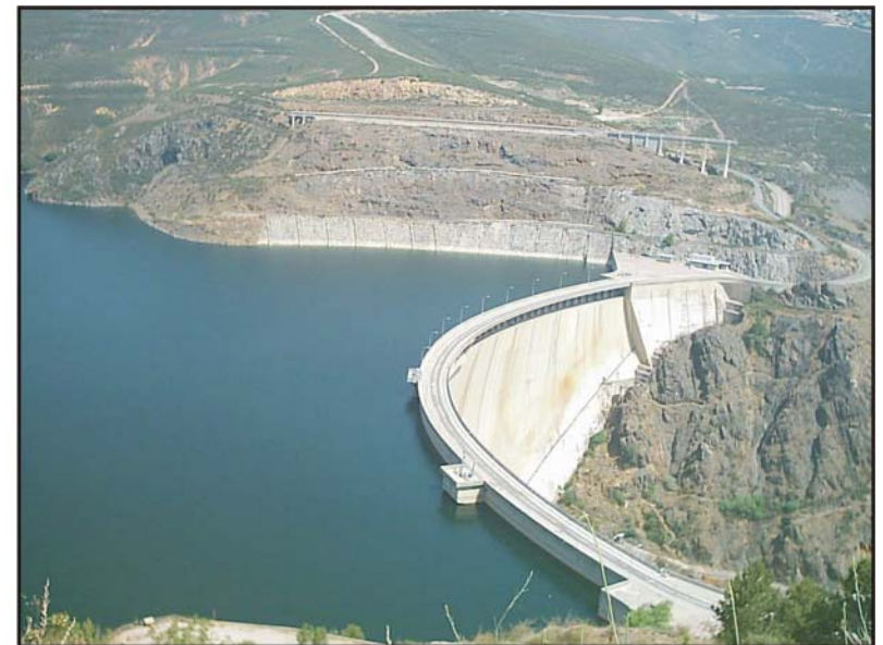
Figura 21: Presa El Atazar.
