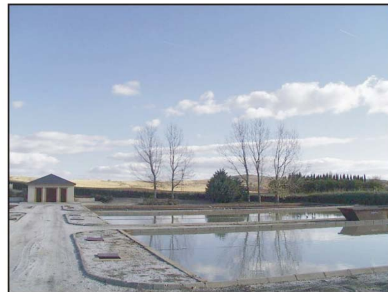
Figura 43: EDAR de Torrelaguna.
