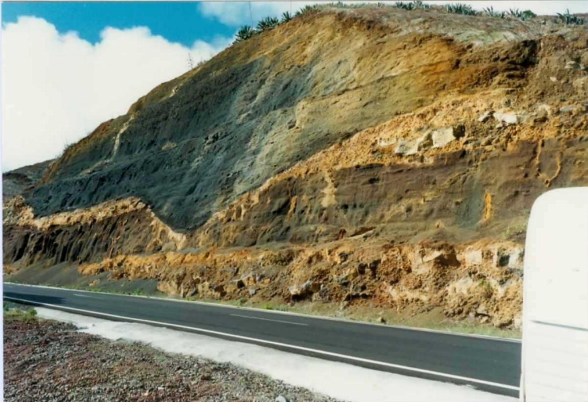
Fot.nº16.- Otro aspecto de la trinchera de la fotografía anterior, en la cual se observa un paleorrelieve rellenado por depósitos piroclásticos de una emisión subsiguiente.
