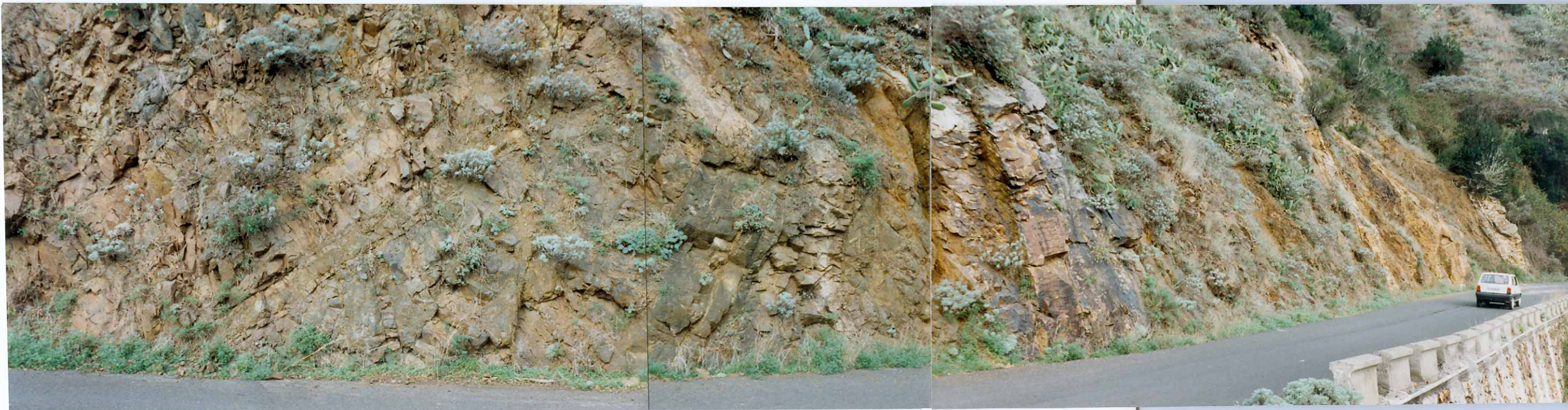
Fot.n961.- Panorámica del contacto entre el Complejo Basal (CB) y el Complejo Traquítico-Fonolítico (CTF). Las rocas plutónicas del C.B. están atravesadas por una malla de diques tendidos y poco potentes que buza hacia el interior, mientras que la malla de diques del CTF. son más potentes y subverticales.
