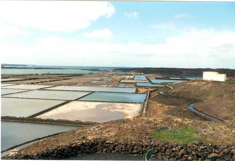
Fot. 35.- Vista de las salinas de Janubio, en explotación. Autor: R. Balcells Edad: Cuaternario
