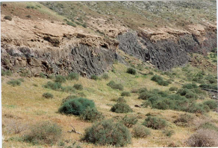
Fot. 9.- Detalle del frente de deslizamiento de la foto anterior. Se observa que el deslizamiento afectó a depósitos piroclásticos de dispersión de edad cuaternaria.
