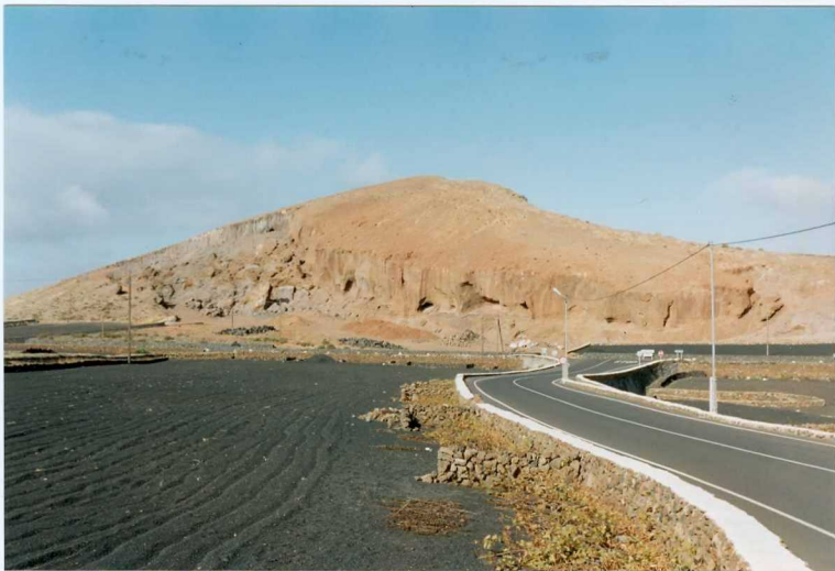
Fot. 28.- Panorámica del edificio Montaña de los Dolores muy afectado por antiguas extracciones de lapilli.
