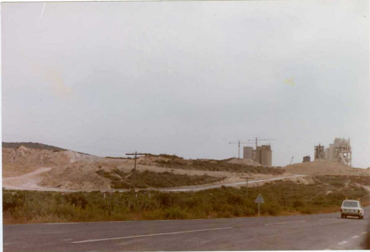
12-45/AD-BA/94.- Canteras en las "capas rojas" del Cretácico Superior-Eoceno inferior (margas y margo-calizas), para la Fábrica de Cemento Alba. Km 8,200 de la carretera Jerez-Algeciras.
