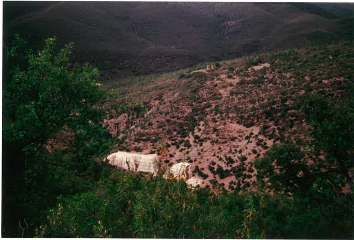
21-34-IN-FL-Fo5.- Escombreras de la Mina El Avellanar en el río Dañador. Las escombreras y los hundimientos se encuentran sobre las cuarcitas y pizarras de las "Capas Pochico" (4). En la Zona de Cizalla Santa Elena-Puente Génave.
