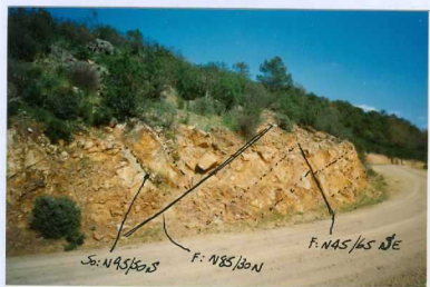
FOTO n° 14.- Zona de fracturación, que afecta a "Los Rasos" y la "Cuarcita Botella". En la foto se observan, al menos 2 planos de fractura: N85/30N y N45/65SE.
