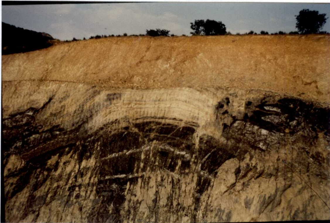
FOTO n° 20.- Pliegue en cofre formado en un tramo de alternancias de areniscas y pizarras dentro de los "Esquistos de Río". Trinchera del F.C. AVE en el valle de El Escorial.
