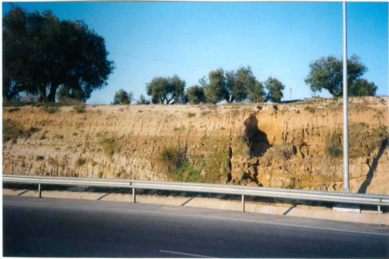
F-9079. Afloramientos de la unidad 12. Rotonda carretera Móstoles-Villaviciosa de Odón.
