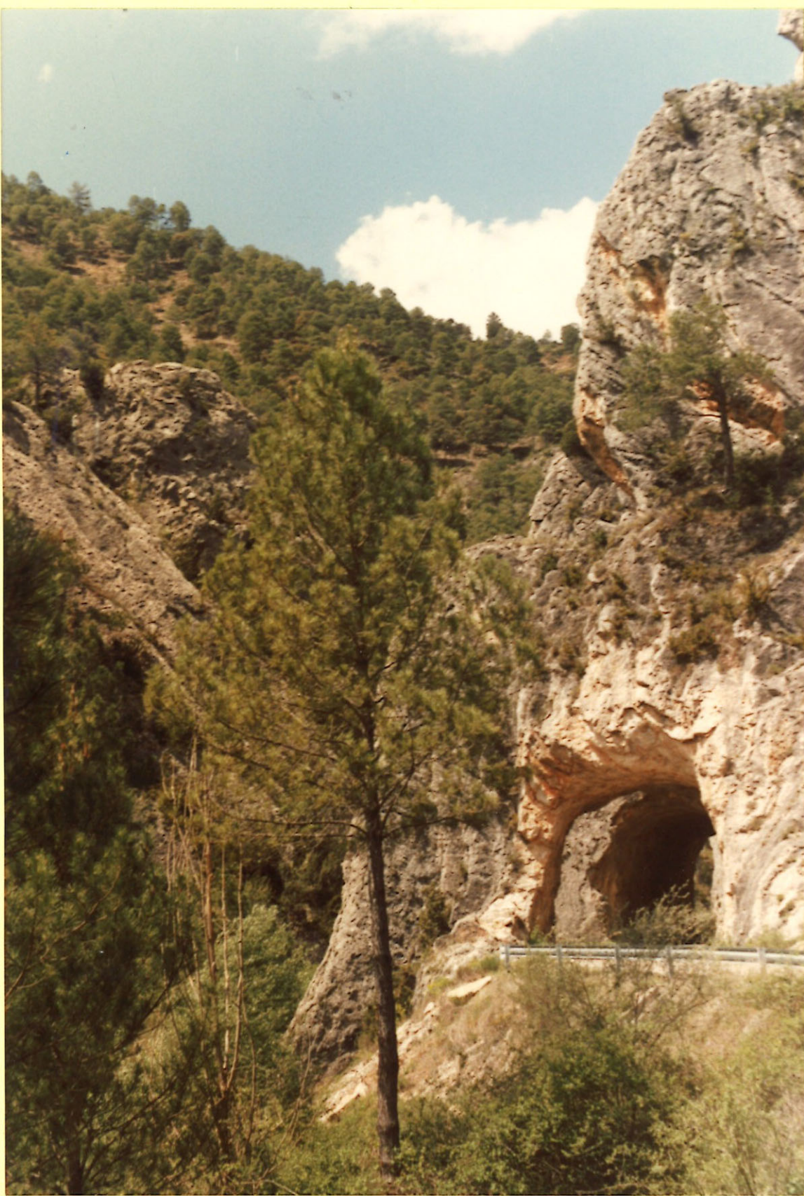
Túnel excavado en las calizas y dolomías del Lías de la Fm. Cuevas Labradas.
