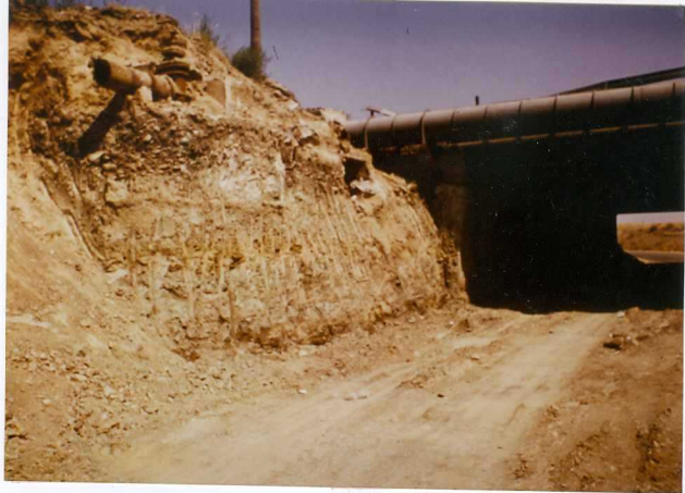
F.59.- Afloramiento de la Unidad 3 (arcillas verdosas con niveles finos de carbonatos dolomíticos) en las proximidades del Puente de San Fernando (carretera N-II). Parte superior cubierta por depósitos antrópicos.
