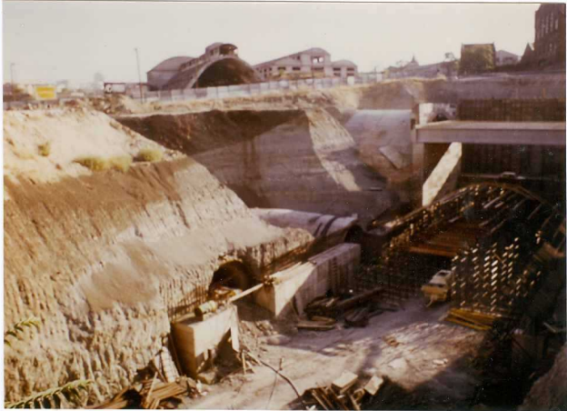
F.62.- Zanja bajo la Estación Eléctrica de Men- dez Alvaro. Arcillas verdes y carbonatos de la Unidad 3 del Mioceno. Obsérvese la disposición de vertidos sobre la serie miocena.
