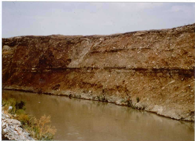
F. 70 - Talud de vertidos estratificados erosionado por el río Manzanares al este del barrio de San Fermín.
