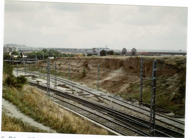
F.76.- Vista general de los depósitos de relleno de canal, preferentemente arenosos, de la terraza de +28-30m., de Villaverde Bajo, en el corte del Ferrocarril.
