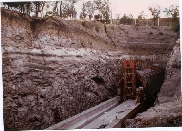
F.27.- Unidad de arcillas verdes con carbonatos y arenas micáceas (6). Colector del P.S.I. en la base del Cerro de La Mesa. Recubrimiento por coluviones arcóscicos cuaternarios.
