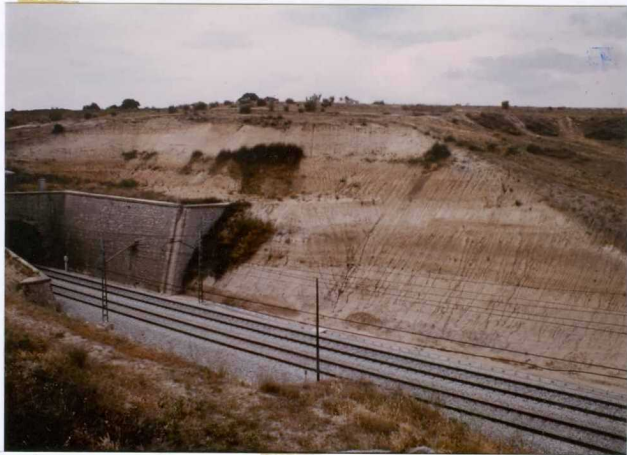
F.47.- Proximidades de la Estación de Pitis. Contacto entre las unidades 9 (Arcosas y Arcillas) y 12 (Arcosas gruesas) del Mioceno. El contacto viene remarcado por el desarrollo de vegetación de juncos.
