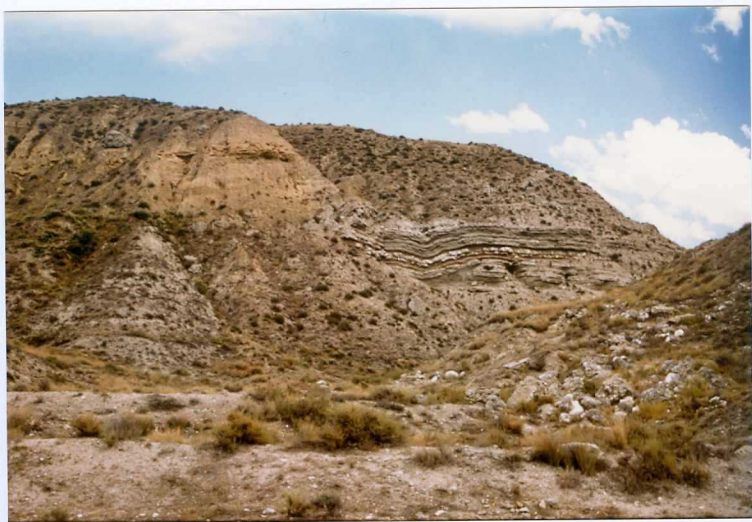
Foto 4.- Inflexión de los yesos aragoneses en los alrededores de Rodén (inmediaciones del punto de observación nº 6), junto al río Ginel. Se interpreta como una subsidencia por disolución de tramos yesíferos infrayacentes.
