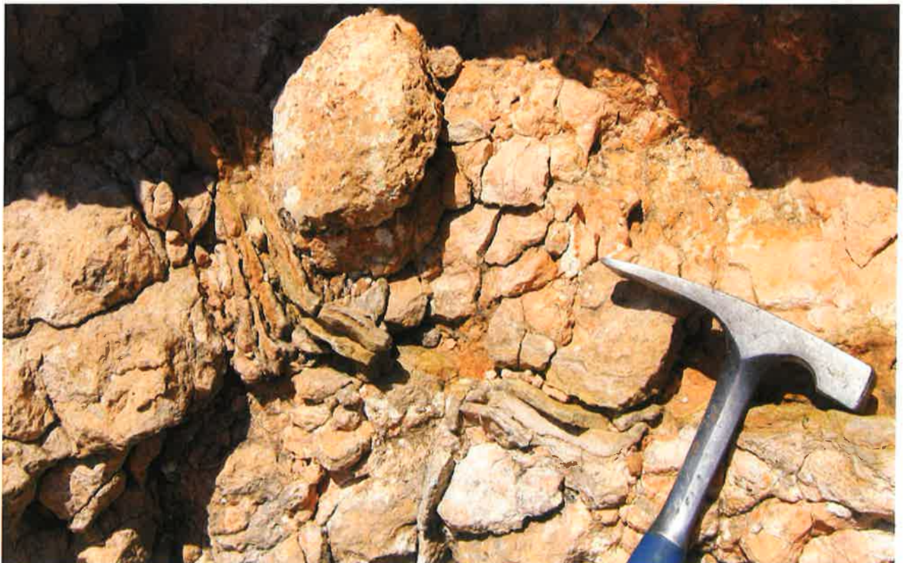
IGFN 8018.- La parte superior de los niveles encostrados (15`) no erosionados por los canales de areniscas y gravas muestran la presencia de costras laminares y brechas de costras, indicando su presencia la existencia de una discontinuidad de cierta importancia relacionada con un periodo de no-sedimentación (laguna estratigráfica).
