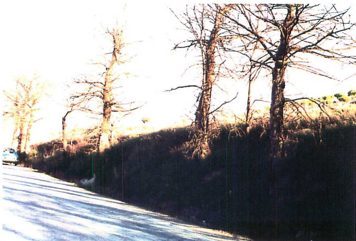
17-14/EP PW/9411 Deformación de troncos de árboles debido a creep de ladera. Carretera Verlevillo - Hérmedes de Cerrato
