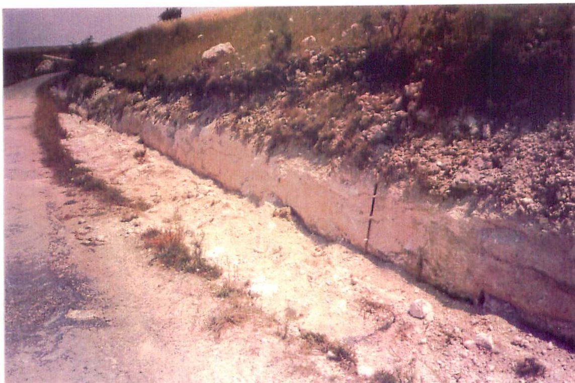
18-10-EP-MA-9615.- Tramo margoso (11) infrayacente a las calizas del Páramo Inferior. VALLESIENSE
