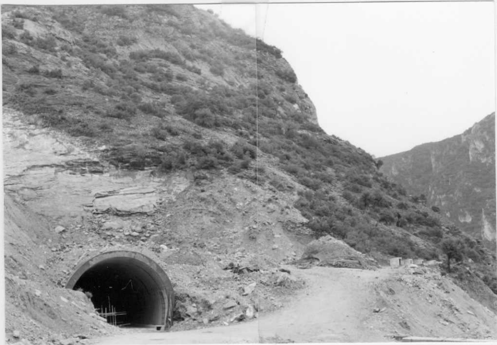
Boca sur del túnel de Covas, excavado en las calizas del Ashgill, salvo la embocadura que aparece en la foto, excavada en esquistos ordovícicos inferiores . Estación AH-528 (
