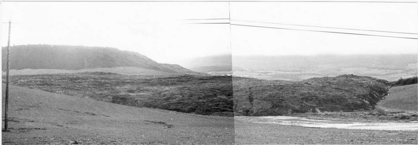
FOTO 300: Fracturas y desplazamientos producidos en las margas por la sobrecarga de una escombrera de sal.
