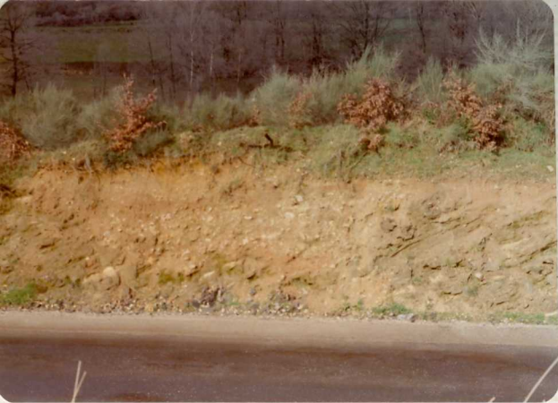
743.- Paleocanal relleno por depósitos terciarios groseros excavado sobre las pizarras de la Serie de Villalba.
