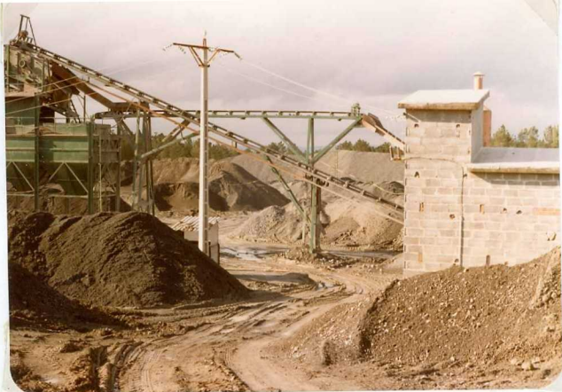
05-08/GP/EK-353 Planta para la producción de áridos de tritura ción , utilizando como materia prima la serpentina (M 50 ) de la cantera de las fotografías 351 y 352.
