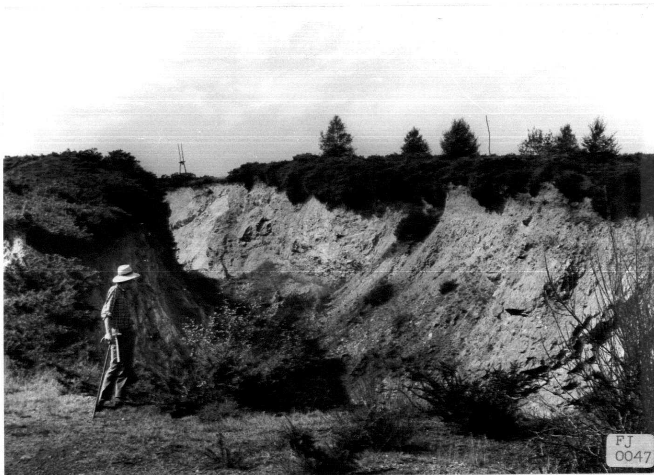
FJ-0047. - Antiguas labores mineras relacionadas con mineral de hierro en la Peña Curiscada, cerca de Villanueva de Oscos. La mineralización se localiza a lo largo de fallas verticales de dirección NW-SE.
