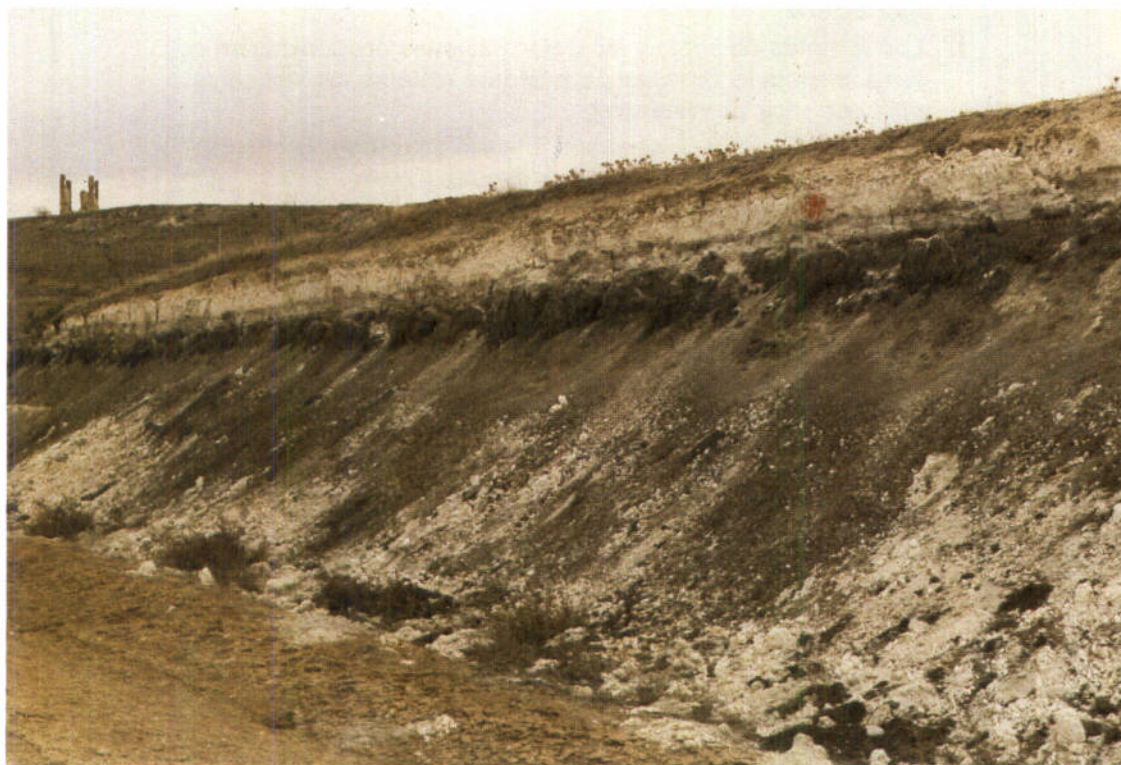
Foto N.º 7.—Desmorte en estratos arcillosos expansivos mostrando el deterioro a los pocos meses de su excavación (Rivas de Vaciamadrid).
