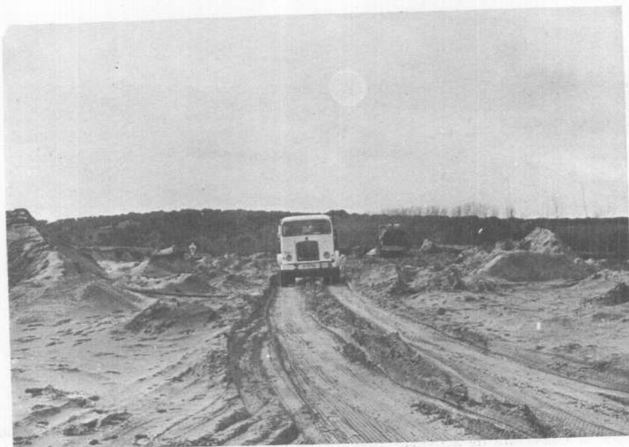
Foto 6.— Explotación de arenas en el río Tormes, aguas abajo de Juzbado (E-42).
