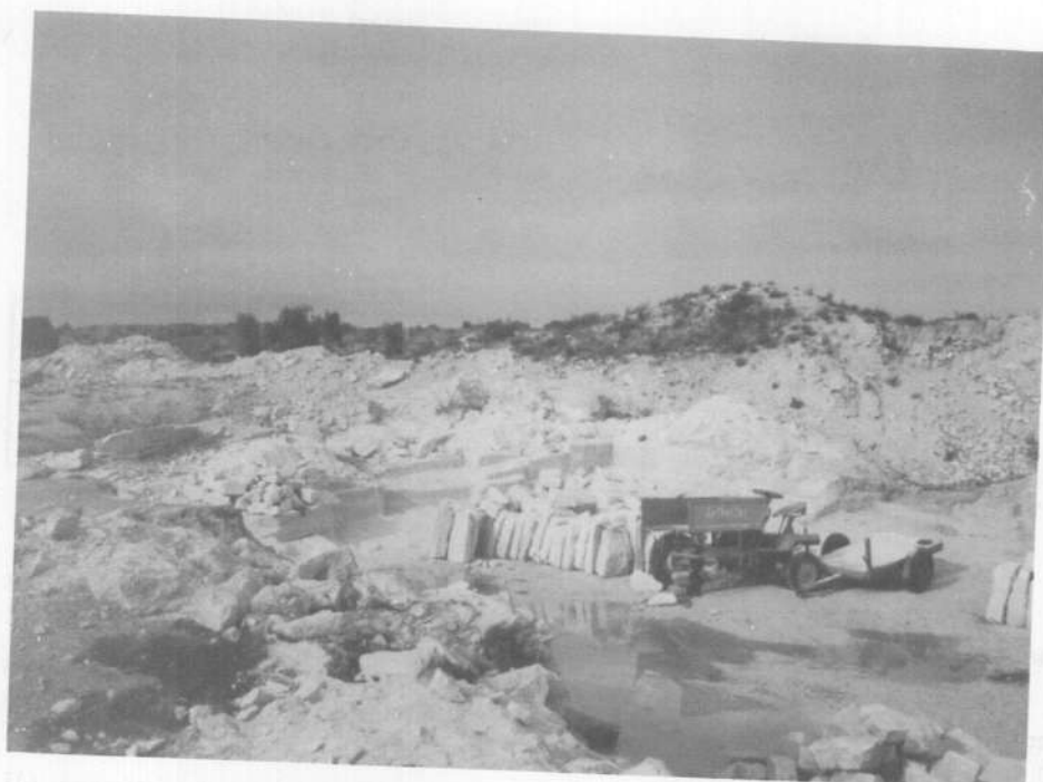
Foto 8.— Explotación de granito para bordillos en Sobradillo de Palomares.
