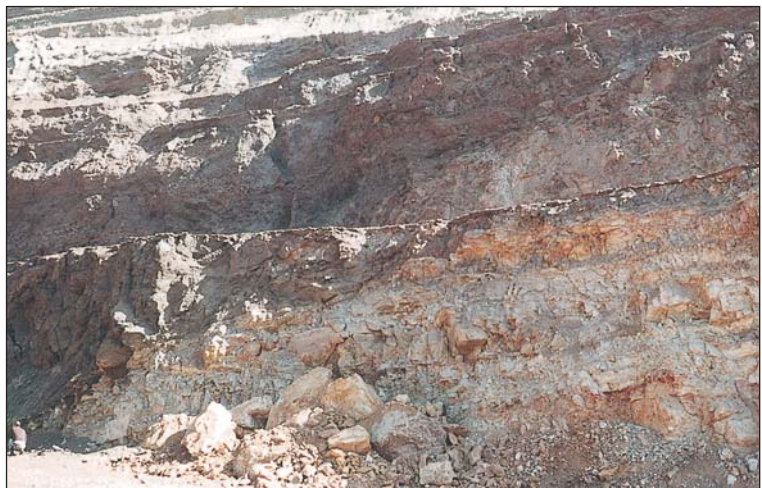
Foto 12.3. Mina de Alquife (corta CAM). Contacto rubial/roca carbonatada, esta última con marcada estratificación.
