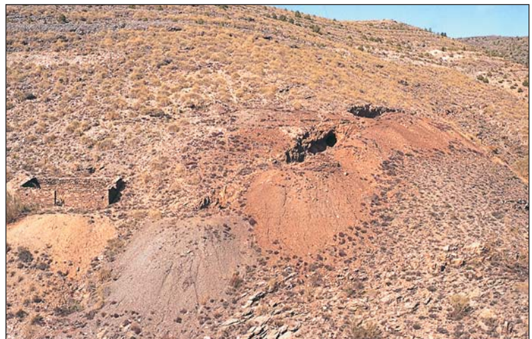
Foto 7.3. Grupo de Fiñana. Mina del Barranco Cocones (indicio 35). Filón marcado por labores en superficie.
