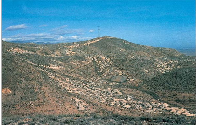
Foto 18.1. Magnesitas de Sierra de Gádor. Panorámica general de las labores del Barranco del Lobo. En la parte central, en gris, escombrera de labor sobre mineralización F-Pb.
