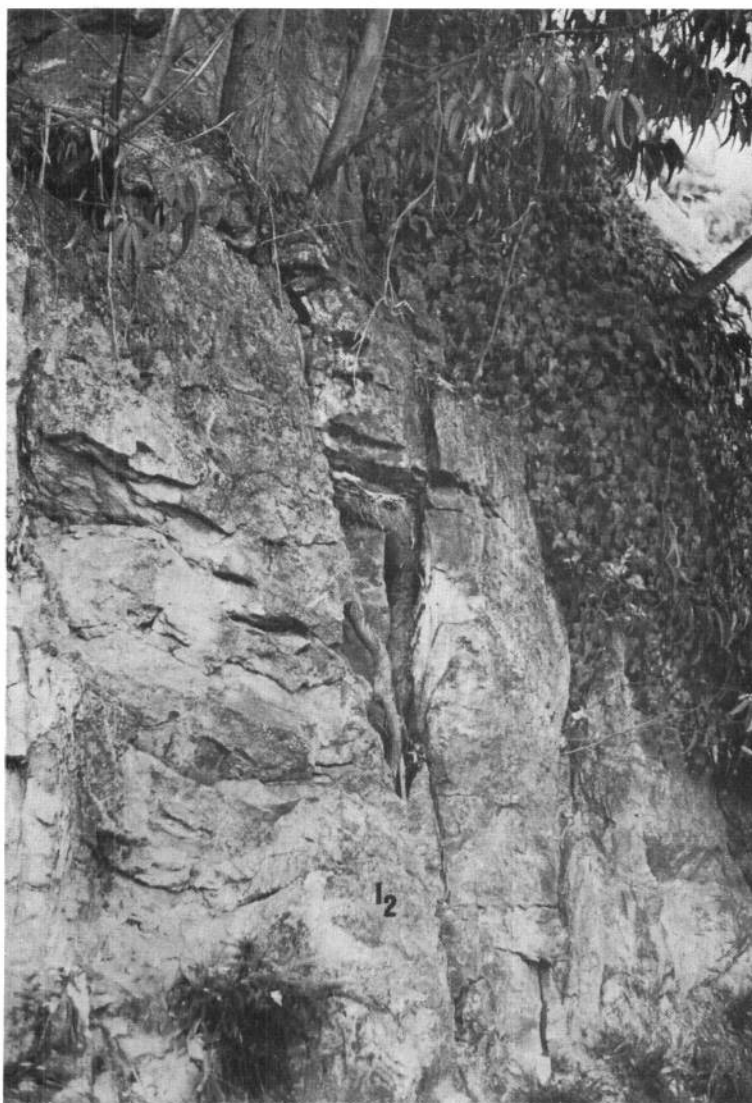
Foto 2.- Deterioro mecánico de un talud (en granito) por la acción de las raíces.
