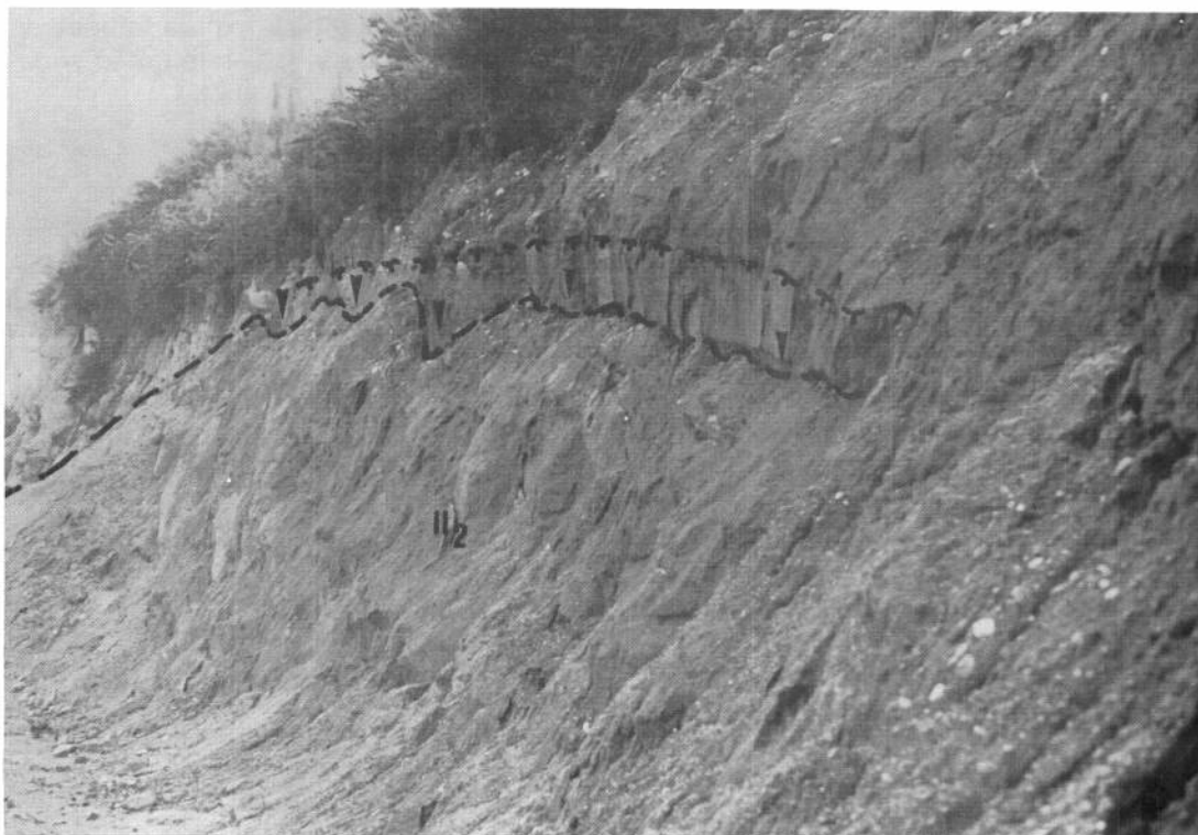
Foto 12.- Inicio de un movimiento por la «cara del talud» (Zona II 2 )
