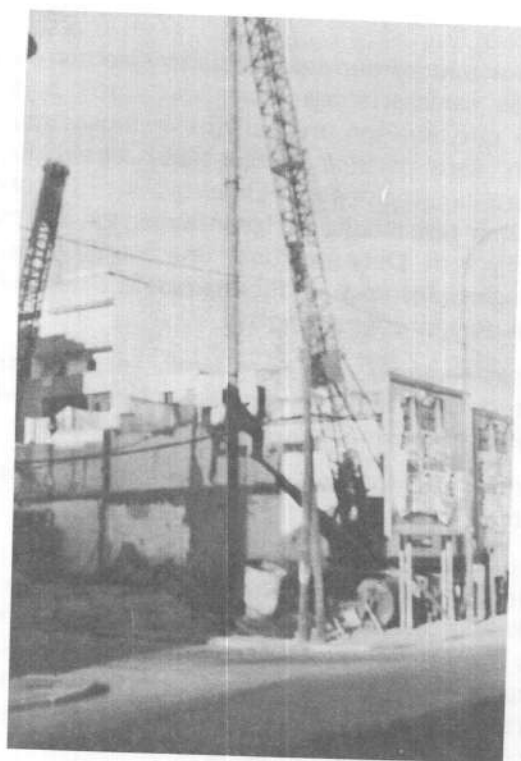
Foto 11. Máquina de ejecución de pilotes excavados en IV 5 (RODIO, S.A.)
