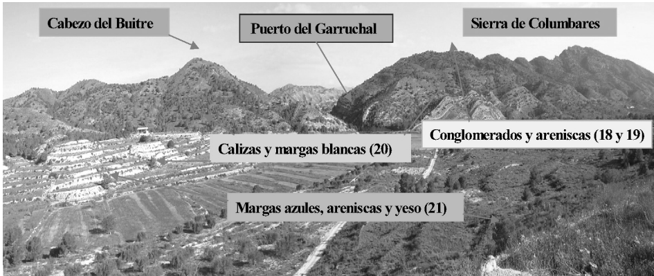
Figura 2.18. (Foto 74). Panorámica del Puerto del Garruchal desde el Collado de Las Zorras. Obsérvese como la Unidad carbonatada (20), tiene un rápido acuñamiento lateral en la vertiente meridional de la Sierra de Columbares. Carretera de Los Garres a Las Casas del Cura.
