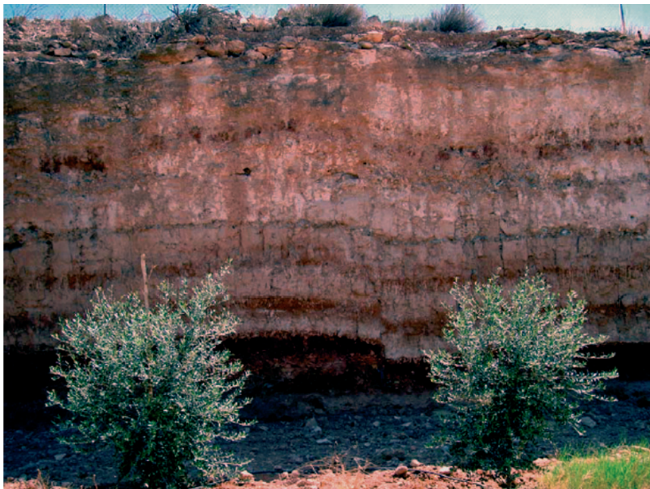
Figura 45. Plan de falla subvertical de carácter inverso, afectando a depósitos aluviales cementados y encostrados de los abanicos del Pleistoceno medio. Sector meridional de la Depresión, al pié del relieve tectónico lineal de Cabezo del Muro (La Escarihuela)
