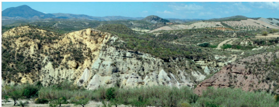
Figura 90. Fallas normales cortando a sedimentos continentales y marinos del Serravalliense-Tortoniense inferior en el PIG de los Morotes. Obsérvese el basculamiento de los sedimentos hacia el noroeste, a la derecha de la fotografía
