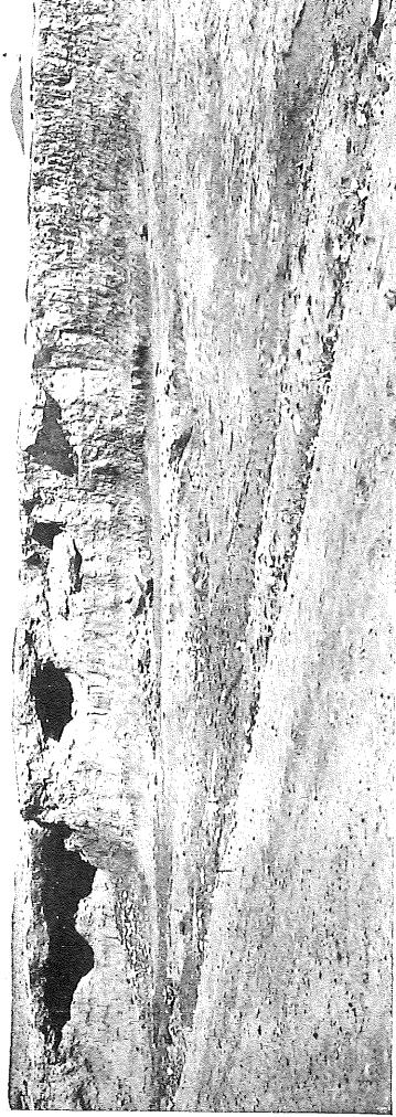
Desmonte Sur de la carretera en construcción de Manzanares a Daimiel, próximo a la general de Andalucía, mostrando materiales miocenos,
