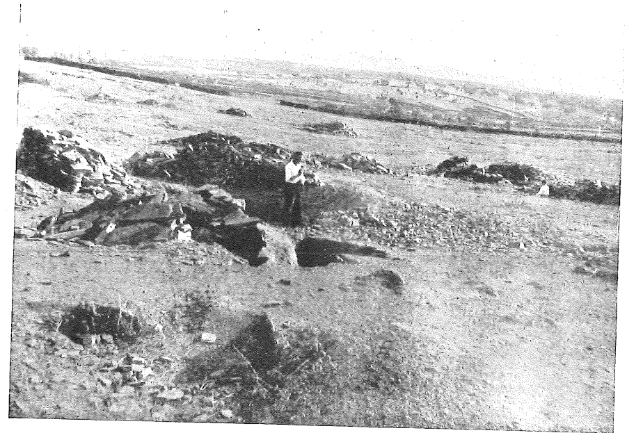
Fig. 2.—Pequeñas canteras de pizarras cambrianas en las inmediaciones del pueblo de Botija. Estos materiales se arrumban hacia los 350^{\circ} , siendo sensiblemente verticales. Son empleados para lanchas de aceras y en el pavimento de las casas de los pueblos cercanos (X-49).
