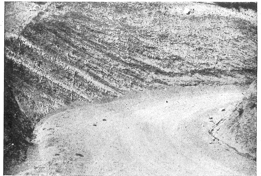
Fot. 10.—Capas margosas paleógenas inclinadas hacia el NO., en la carretera de Torrelaguna a La Cabrera, en el Km. 4,200.
