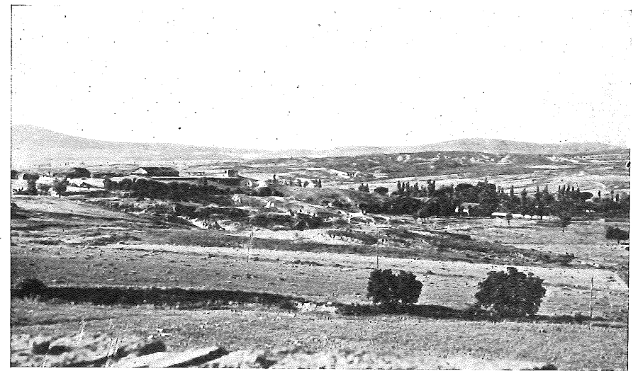
Vista del antiguo establecimiento de preparación de pizarras bituminosas; al fondo, Fuentetoba.
