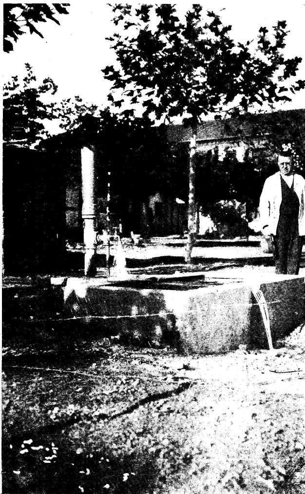
Pozo artesiano, nivel de los 120 metros.
