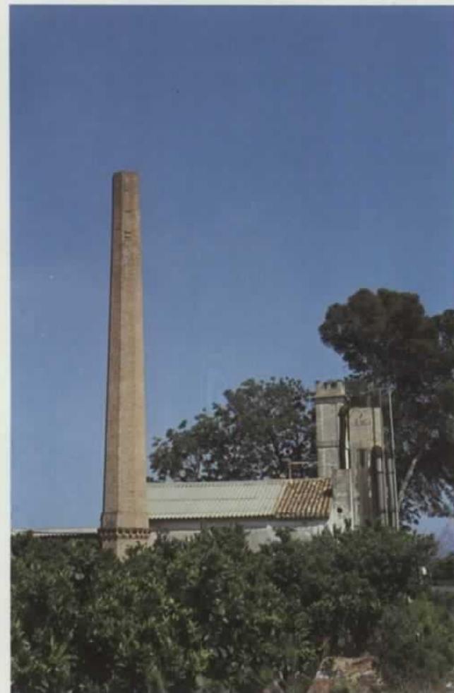
Instalación (ya obsoleta) de vapor para la extracción de agua de pozo cerca de Mirafior, al oeste de Denia.
