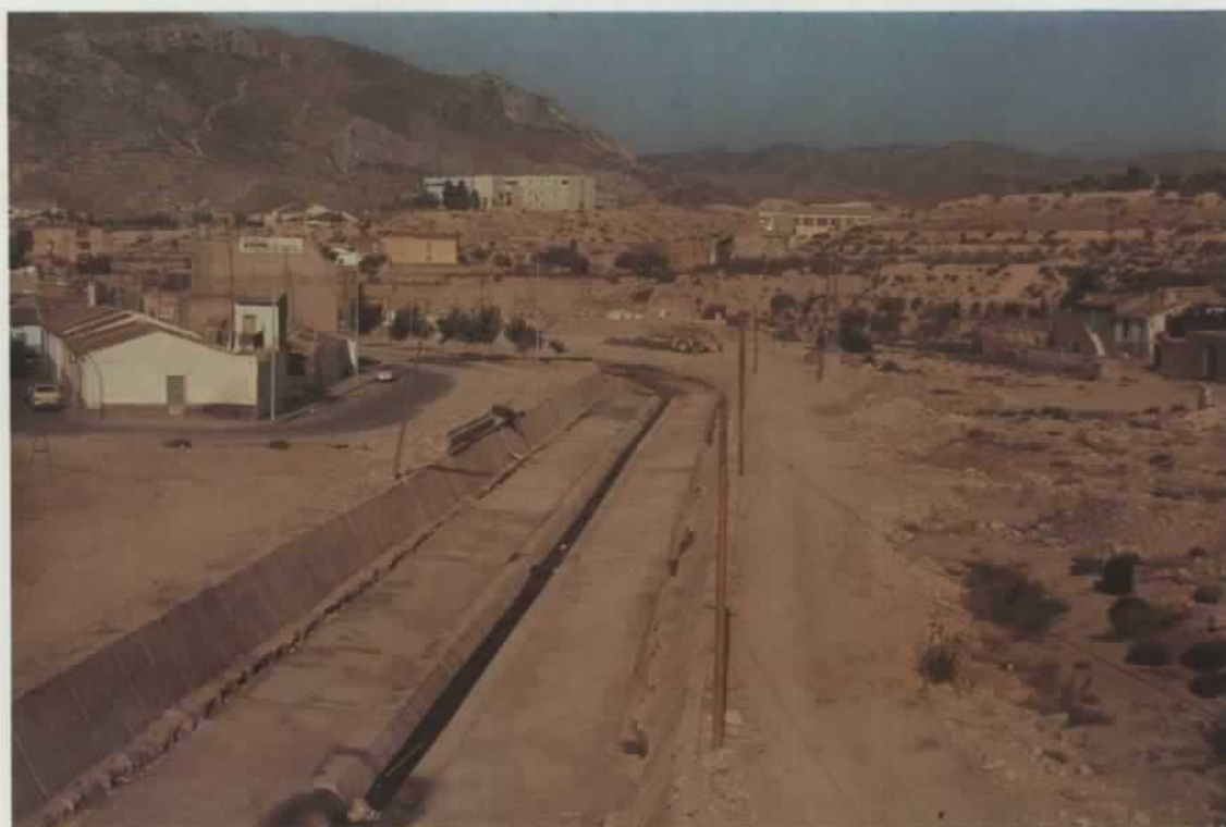
Entre las medidas para paliar los efectos de las avenidas figura el encauzamiento artificial de los cursos. En la fotografía, el encauzamiento del Vinalopó a su paso por Elda.
