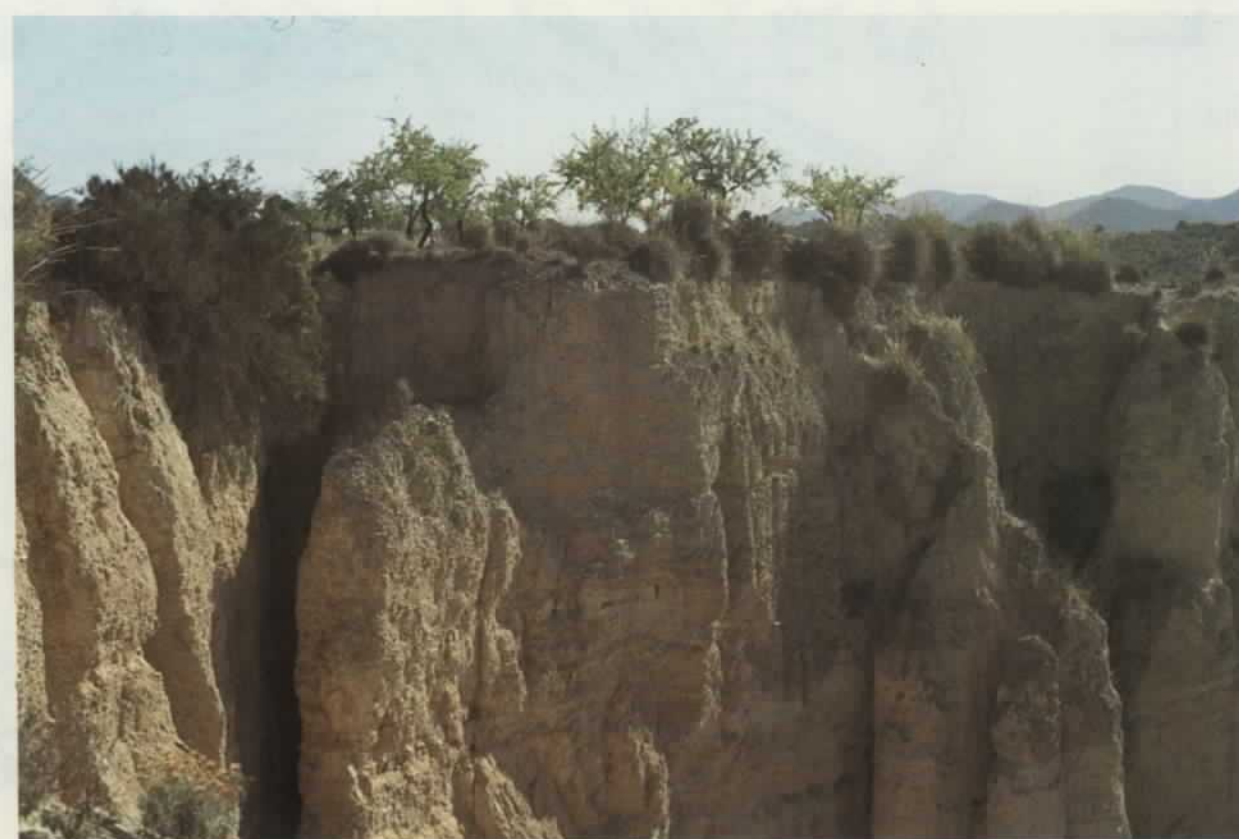
Taludes verticales en barrancos, en la carretera Jijona - Benifallim. Riesgo de desplomes.
