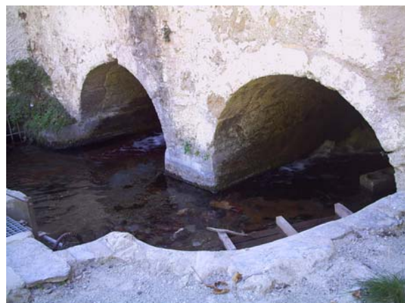
Molino (en reparación) al que llega el agua de una acequia (Punto 13 de la fig. 9) (Jorge Jiménez Sánchez)
