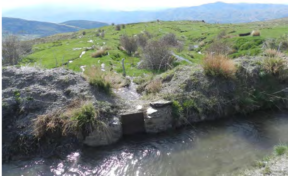
Figura 5.5. Fotografía de la sima de Bérchules. En la imagen se observa el vertido de agua desde la acequia de El Espino para su infiltración en el acuífero.
