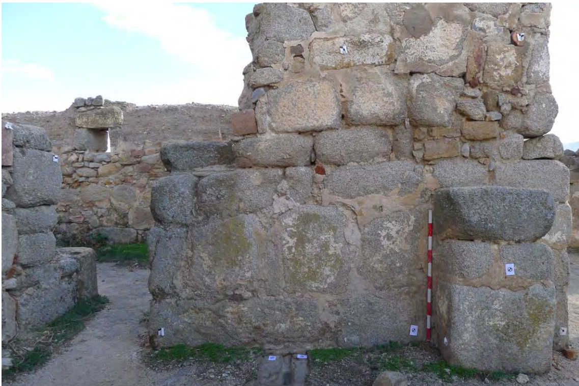
Fig. 2. Alzado del muro sur del espacio del anteábside, con el vano oriental de la habitación angular y el pilar oriental del crucero
