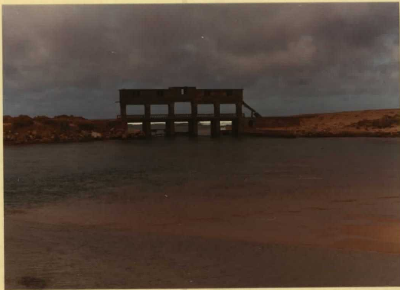
Compuertas que en su día construyó la empresa moluscultora en el canal de desagüe de la laguna.
