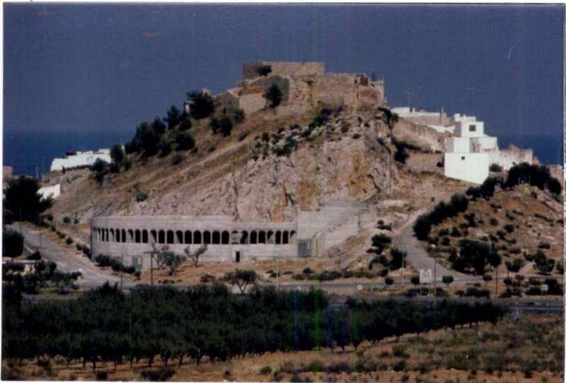
FOTO N° 11. Ejemplo de aprovechamiento del espacio dejado por una cantera en el pueblo de Oropesa.
