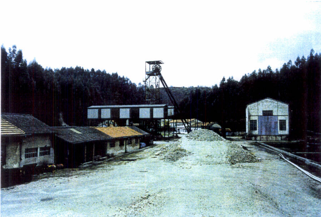
Pozo San Ismael e instalaciones de exterior de la explotación minera actualmente regentada por la empresa Espato de Villabona, S.A.
