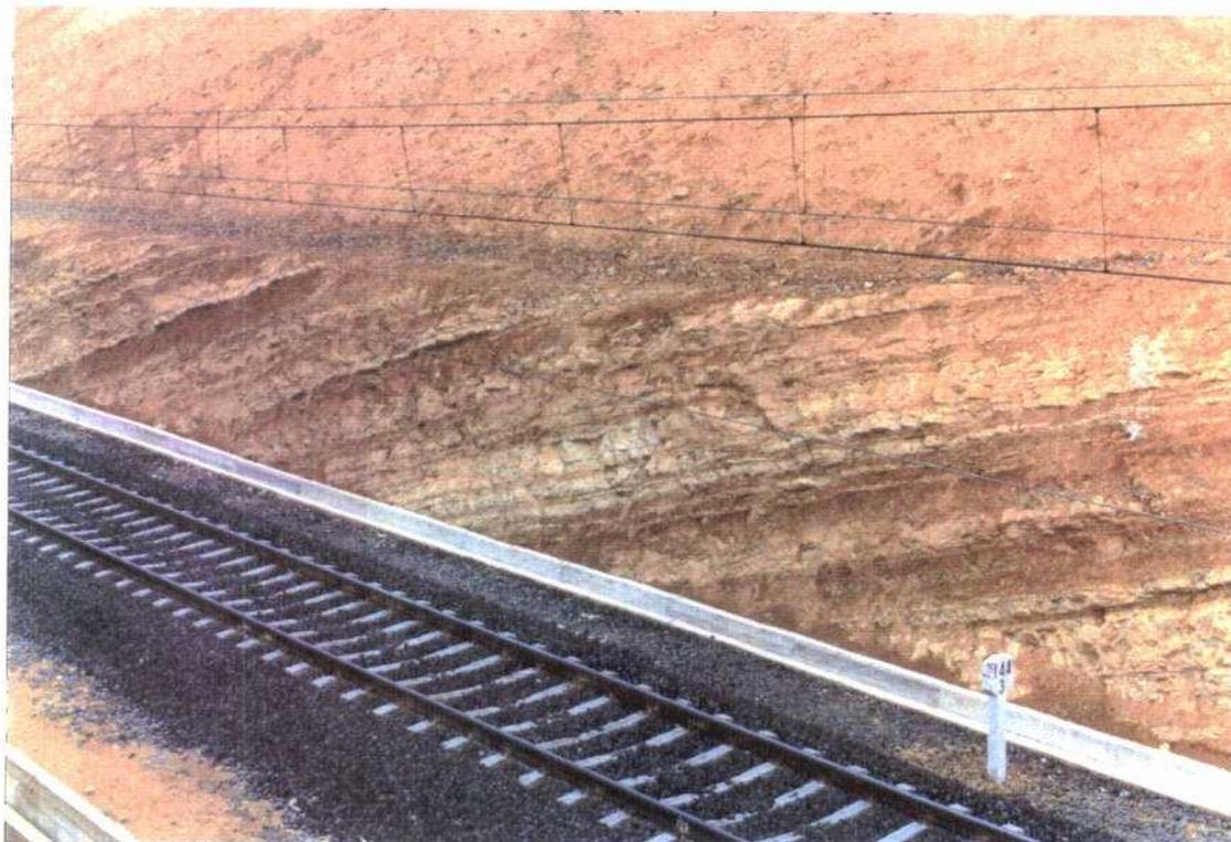
Foto 21.- Arcillas rojas, grises y beigeas, limosas; limos arenosos y arenas finas limosas, a veces con cemento de carbonatos, y margas limo-arenosas, que constituyen la unidad 59. Los materiales se organizan en secuencias estrato- y grano-crecientes, y estrato- y grano-decrecientes. Trincheras del ferrocarril entre Miranda de Ebro y Badauri.
