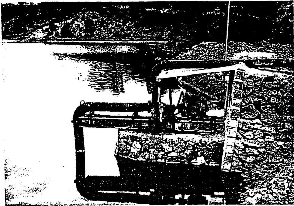
*Fig. 9.9 Pequeña instalación de bombeo, elevable con la balsa.*
