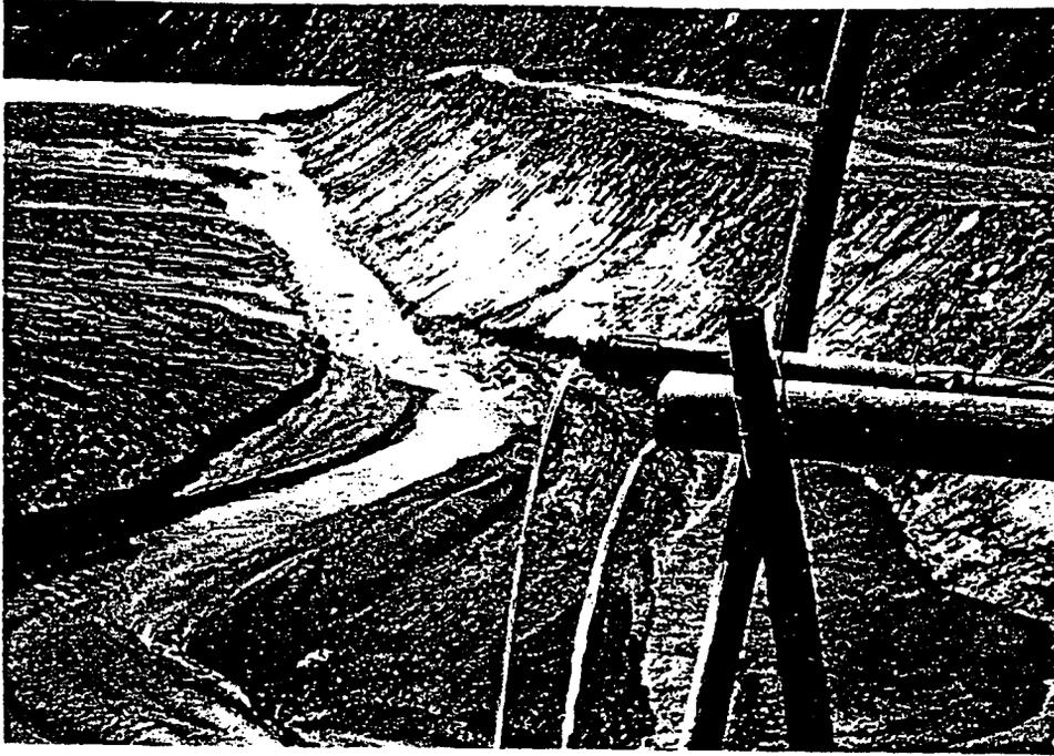
*Fig. 6.7. Vertido puntual de lodo. Obsérvese la acumulación de agua contra el dique.*
