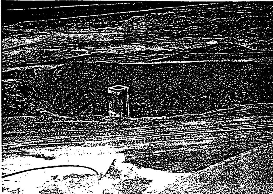
Fig. 9.8 Chimenea de drenaje. En primer término el material filtro a colocar en torno a la misma.
